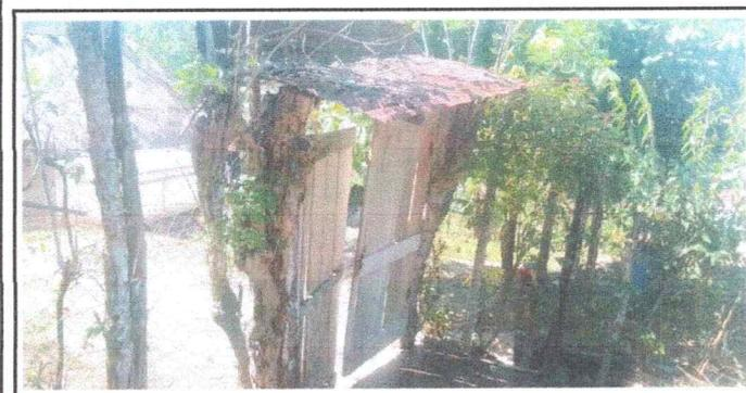
Foto 5: Se observa el portón de madera en mal estado, se necesita sustituirlo por uno de metal para mayor seguridad de los niños.
