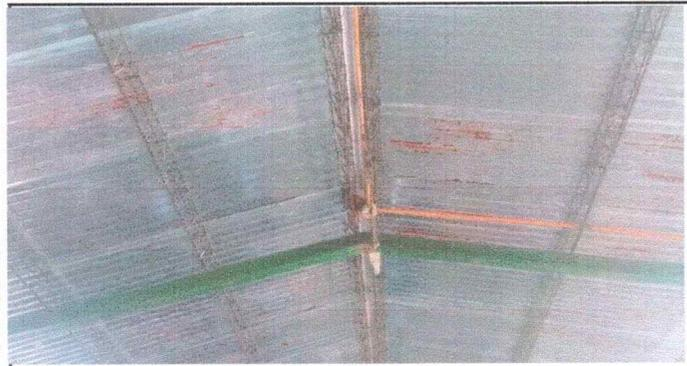
Foto 1. Se observa el mal estado de la estructura y cubierta de la lámina del módulo 1 del establecimiento.
