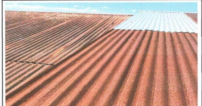
4. Se observa el mal estado de las láminas onduladas, donde en épocas de invierno filtra la lluvia.
