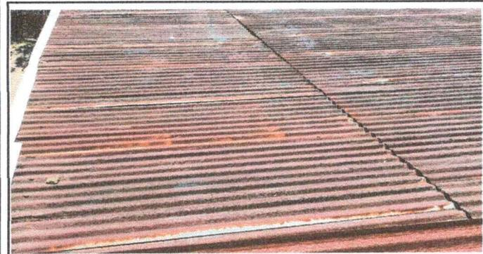
Foto 3: Se observa el deterioro de la cubierta de lámina, se necesita sustituirlo por lámina troquelada calibre 26.
