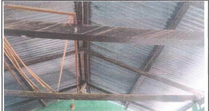
Foto 2: Se observa el mal estado de las vigas, se necesita cambiarlas por estructuras metálicas.
